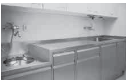
Ausgussraum mit Steckbeckenreinigung.
