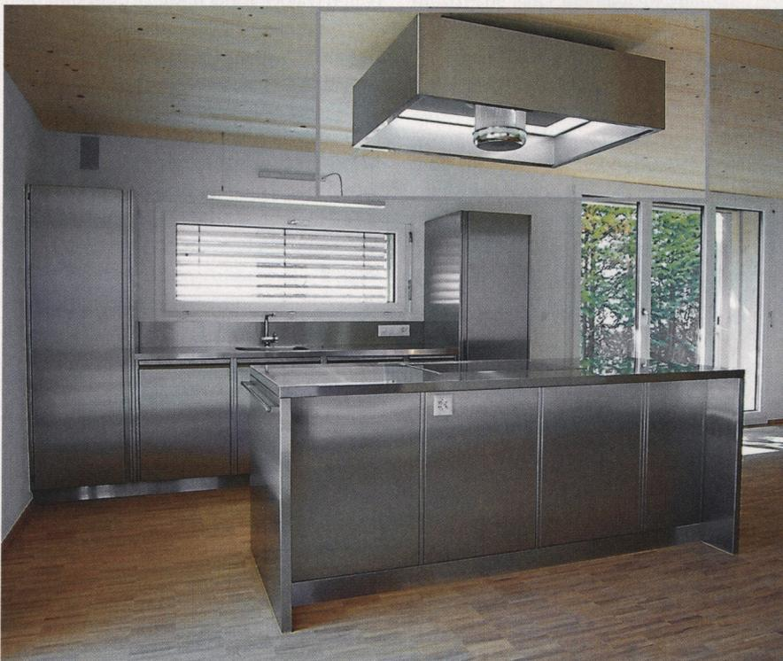
Im Zwischenraum zur Decke wird die gefilterte Luft ausgeblasen. Die austretende Luft bewirkt eine zirkuläre Luftbewegung rund um die Kochstelle, sodass die Raumluft erfasst und durch die Filter geleitet wird.
