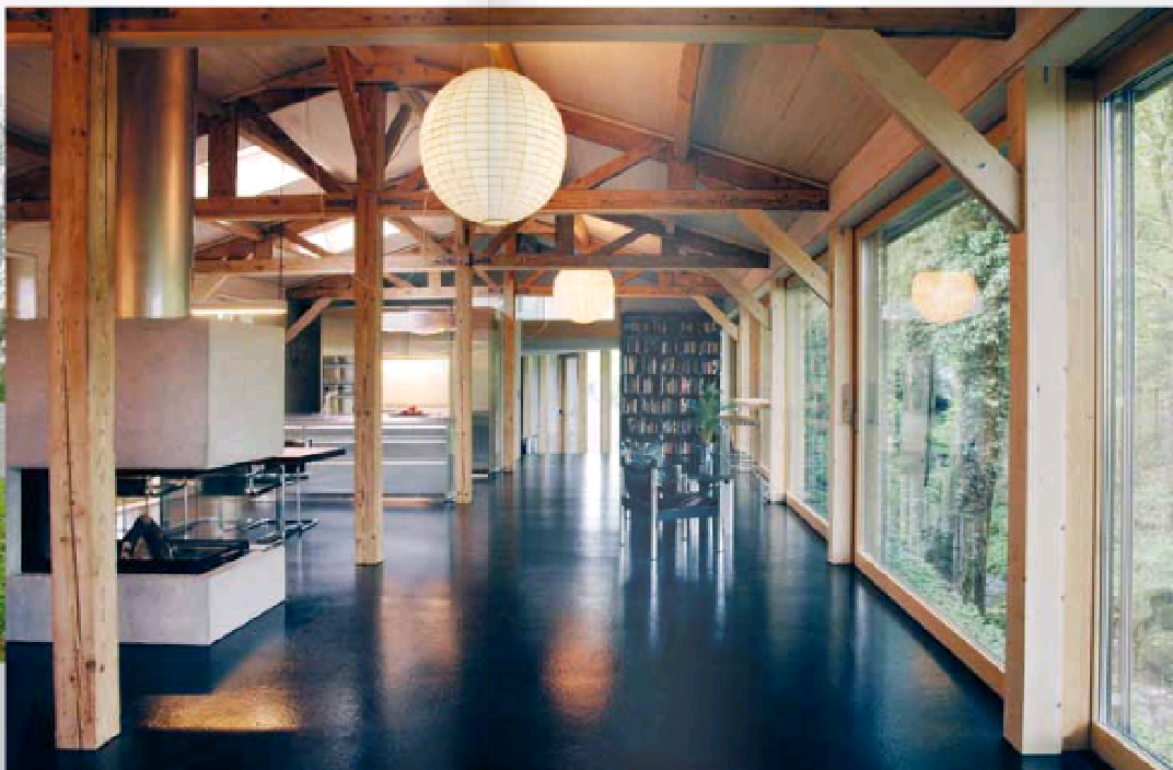
Aus zwei alten Baracken ist ein Wohnhaus erster Güte entstanden. Die einfache, unauffällige äussere Erscheinung musste Bauzonen-technisch beibehalten werden, ebenso die Holzkonstruktion im neuen Wohnbereich, der nach dem Minergie-Standard von einer Pelletheizung und Solarzellen beheizt wird.
